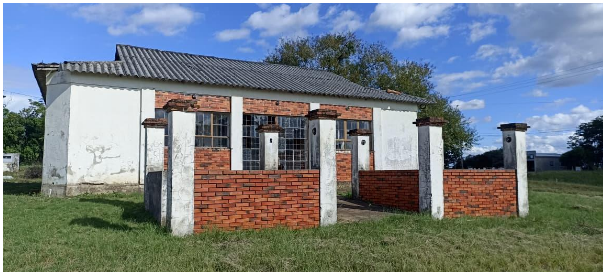
Vista aproximada da fachada frontal, permitindo melhor visualização dos elementos construtivos existentes e das áreas que serão objeto de intervenção.
