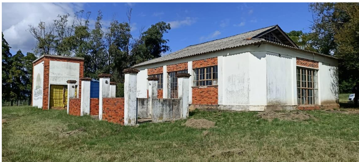
Vista geral do conjunto edificado, contemplando o prédio principal e os volumes frontais que integram o objeto da reforma.
