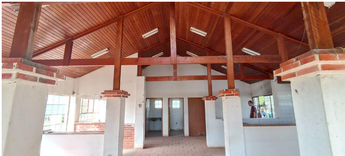
Vista interna dos ambientes existentes.
