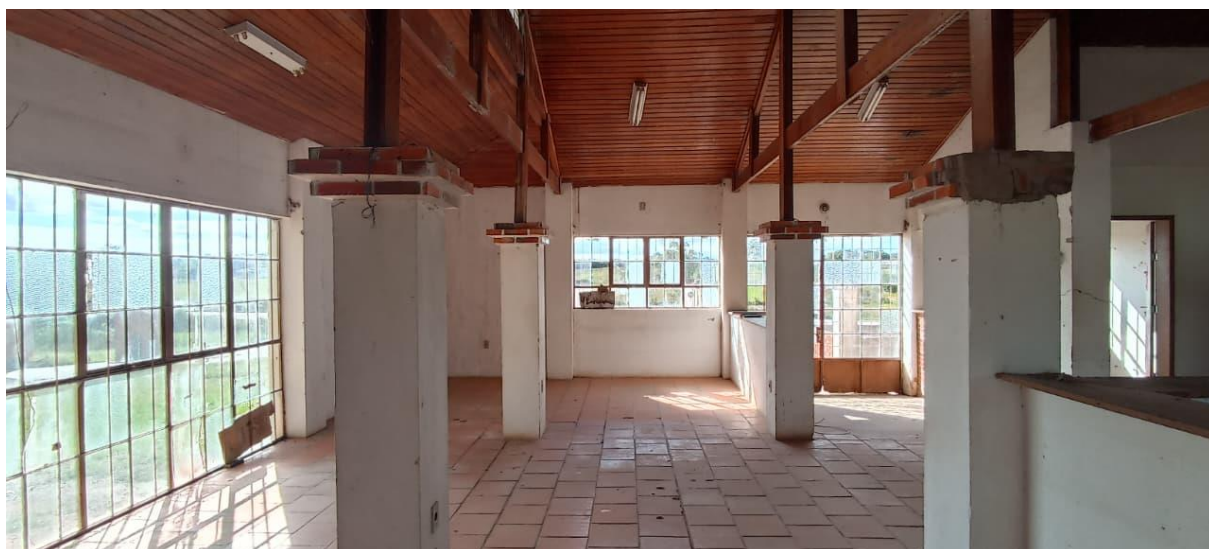
Vista interna do salão principal da edificação.
