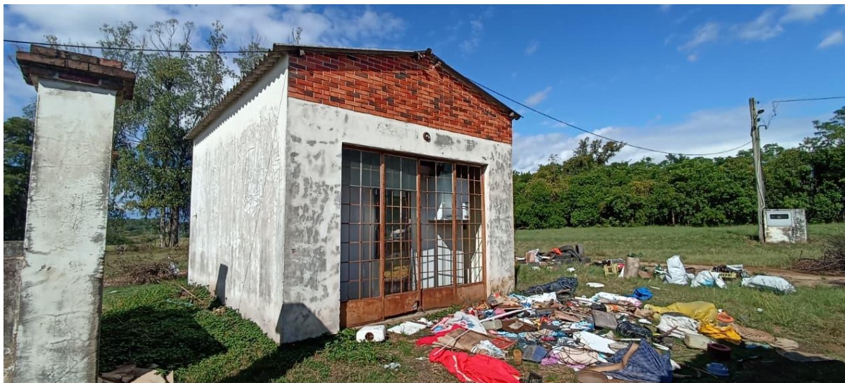
Vista da fachada frontal da edificação destinada à câmara fria, integrante do conjunto da intervenção.
