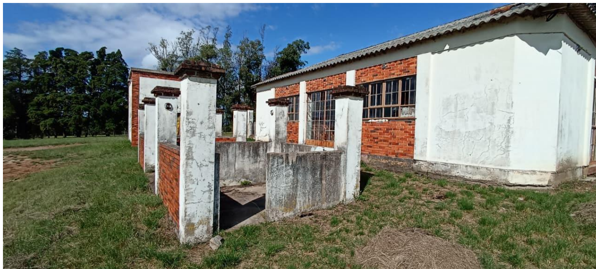
Vista dos volumes frontais existentes, evidenciando suas características construtivas e estado atual de conservação.
