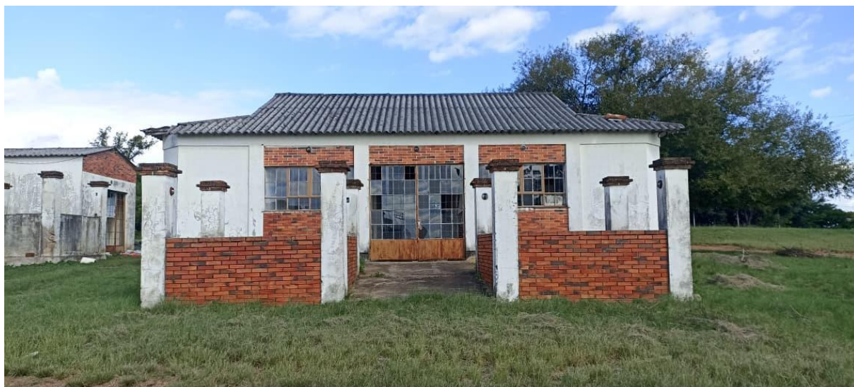
Vista geral da fachada frontal (orientação norte) do prédio principal e dos volumes frontais, evidenciando as condições construtivas existentes.
