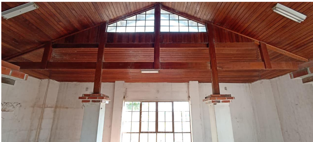
Vista interna do prédio principal, evidenciando as condições existentes.
