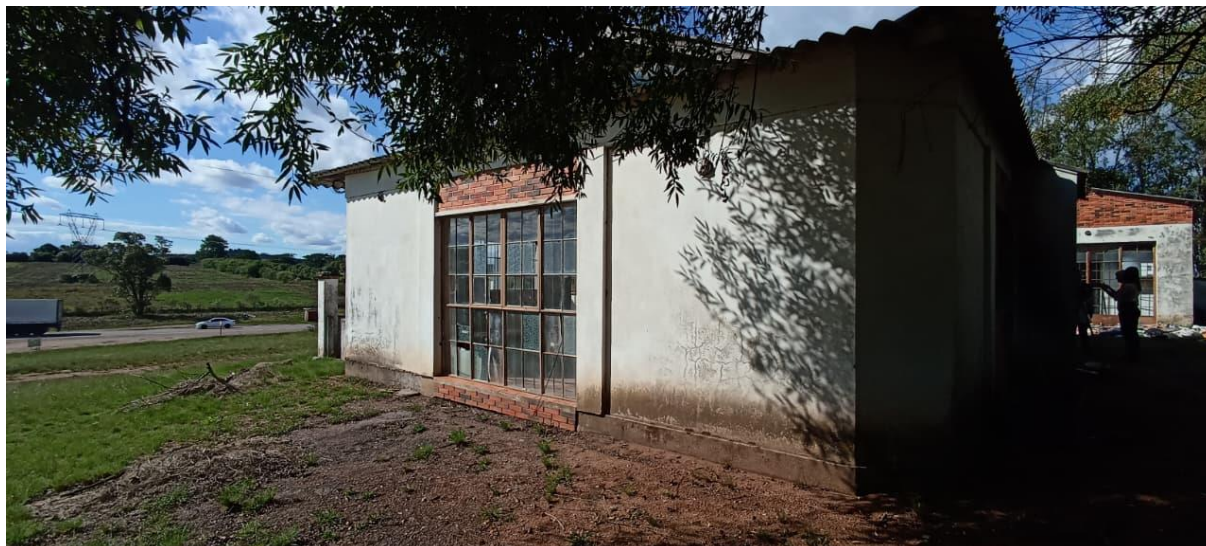
Vista da fachada lateral (orientação leste) do prédio principal, evidenciando as características construtivas.
