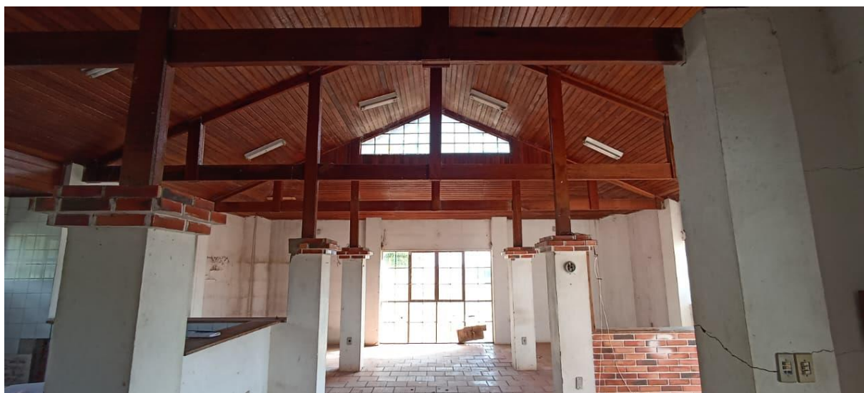
Vista dos revestimentos, pisos e elementos construtivos existentes.
