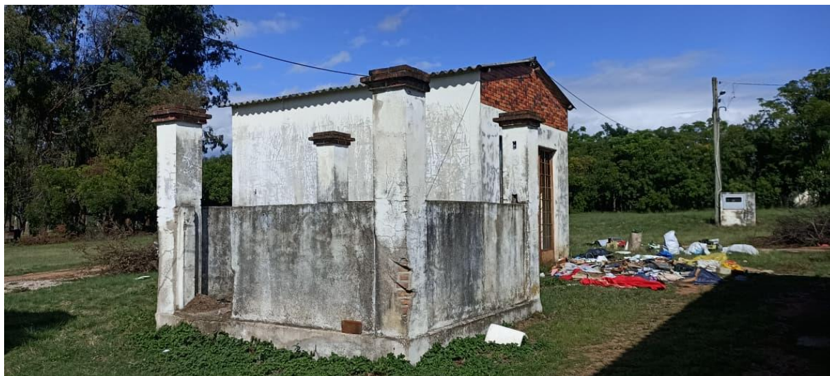
Vista da fachada posterior do prédio de apoio, registrando seu estado atual de conservação.
