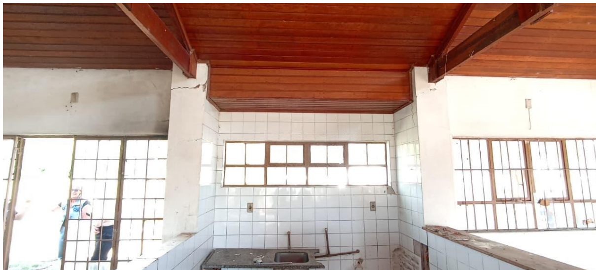
Vista das instalações internas existentes.
