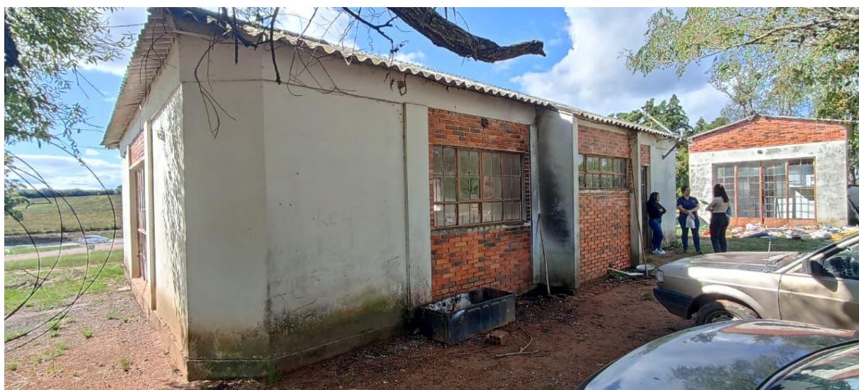
Vista da fachada posterior (orientação sul) do prédio principal, registrando as condições existentes antes da intervenção.
