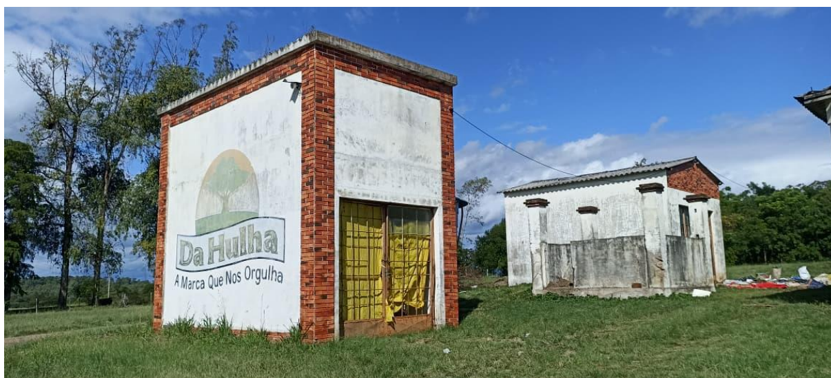
Vista da fachada frontal do prédio de apoio (serviços), integrante do conjunto da edificação objeto da reforma.
